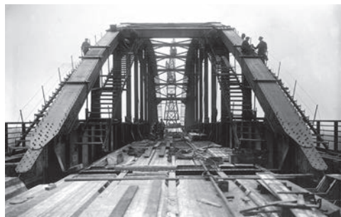
De Weesperbrug in aanbouw, 1936.
